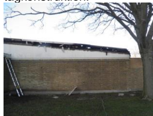
Den brandskadede tagkonstruktion.
