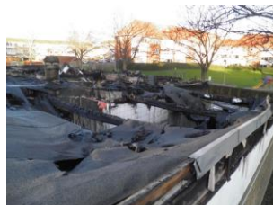
Den brandskadede tagkonstruktion.
