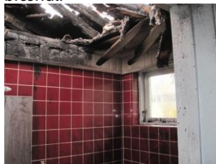
Tagkonstruktionen er brændt.
