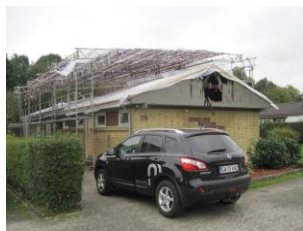
Tagkonstruktionen er brændt.
