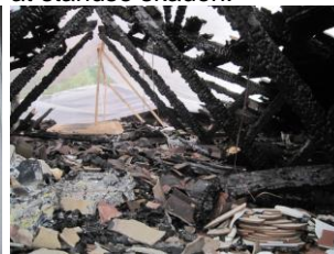
Overdækning etableret for at standse skaden.
