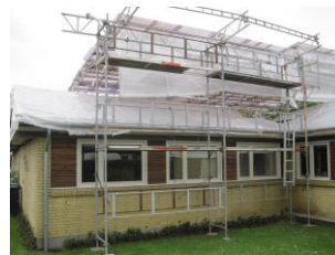
Overdækning etableret for at standse skaden.
