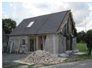
Del af huset er revet ned
