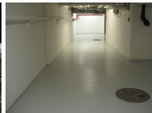
Gulve og vægge renoverede og nymalede.
