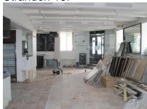
De beskadigede bygningsdele fjernes.
