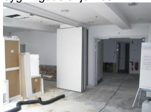
Affugtning i gang.
