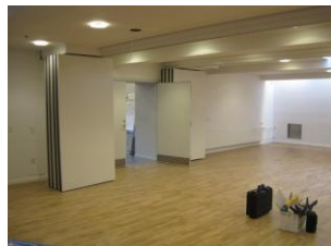
Nyt gulv lægges.
