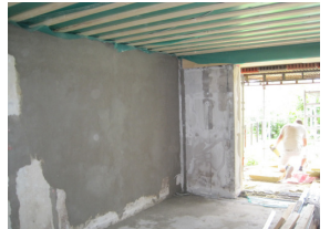
Indvendig genopbygning pågår
