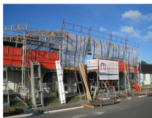
Stilladsoverdækning, genopbygning uanset vejrlig
