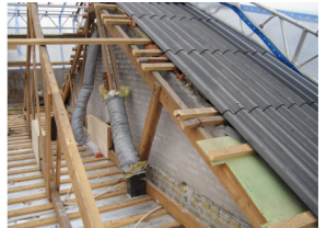
Genopbygning af tagkonstruktion
