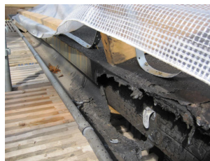
Brandskaded tagkonstruktion
