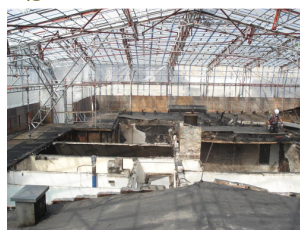
Brandskaded tagkonstruktion
