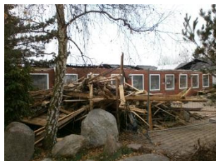
Tagkonstruktion udbrændt
