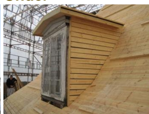
Kvisten genopbygges og undertag etableres
