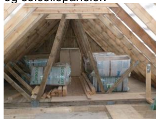
Tagetage – spær er afrenset for sod inden genopbygning.
