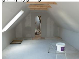
Tagetage – gipsplader er monteret.
