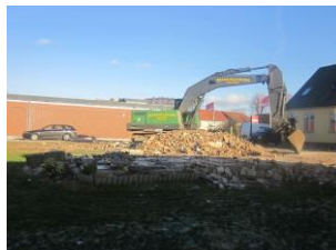
Nedrivning af pizzeria og baghus.
