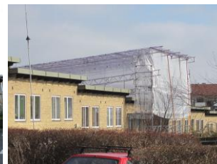
Totaloverdækning under nedrivningen.
