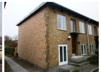
Gavl og facade mod haven er bygget op på ny.
