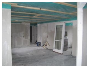
Stuer under genopbygning
