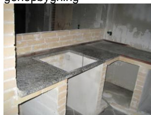
Køkken under genopbygning
