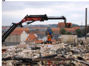
Nedrivning blev igangsat hurtigt
