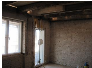
Lejlighed, der er nedrevet helt..
