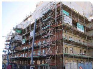
Stillads og overdækning, genopbygning er i gang.
