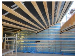
Tag og ydervægge lukkes.
