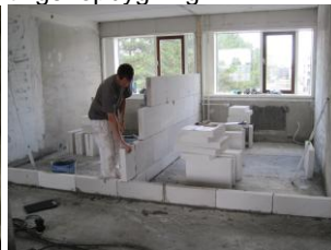
Genopbygning i gang.
