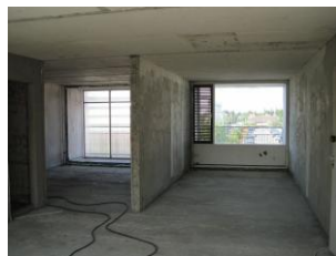
Lejlighed nedrevet og klar til genopbygning.
