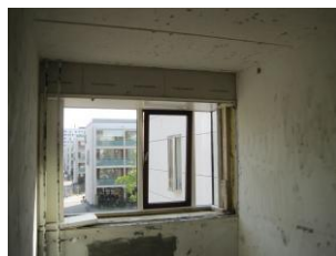
Lejlighed nedrevet og klar til genopbygning.
