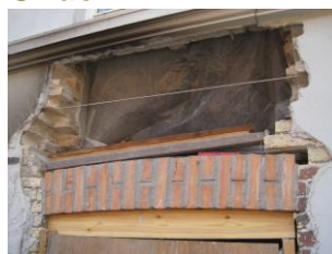
Stik over vindue mures op på ny.
